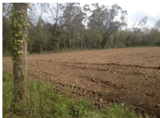
Travaux de remise en état des parcelles dans la plaine de Grimaud (83) - Source : Communauté de Communes Golfe de St-Tropez.
